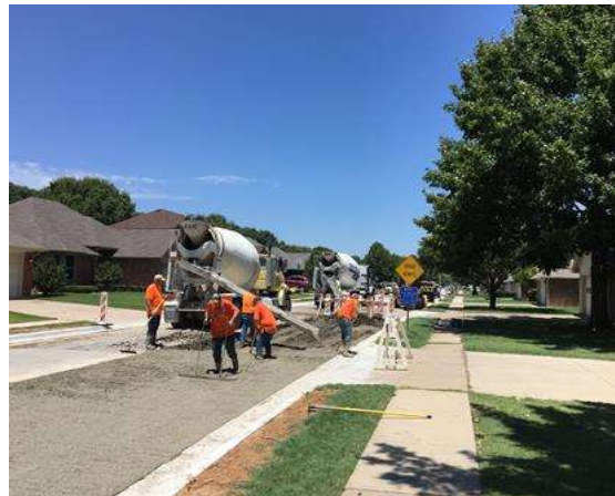
Pouring 227/Concrete
